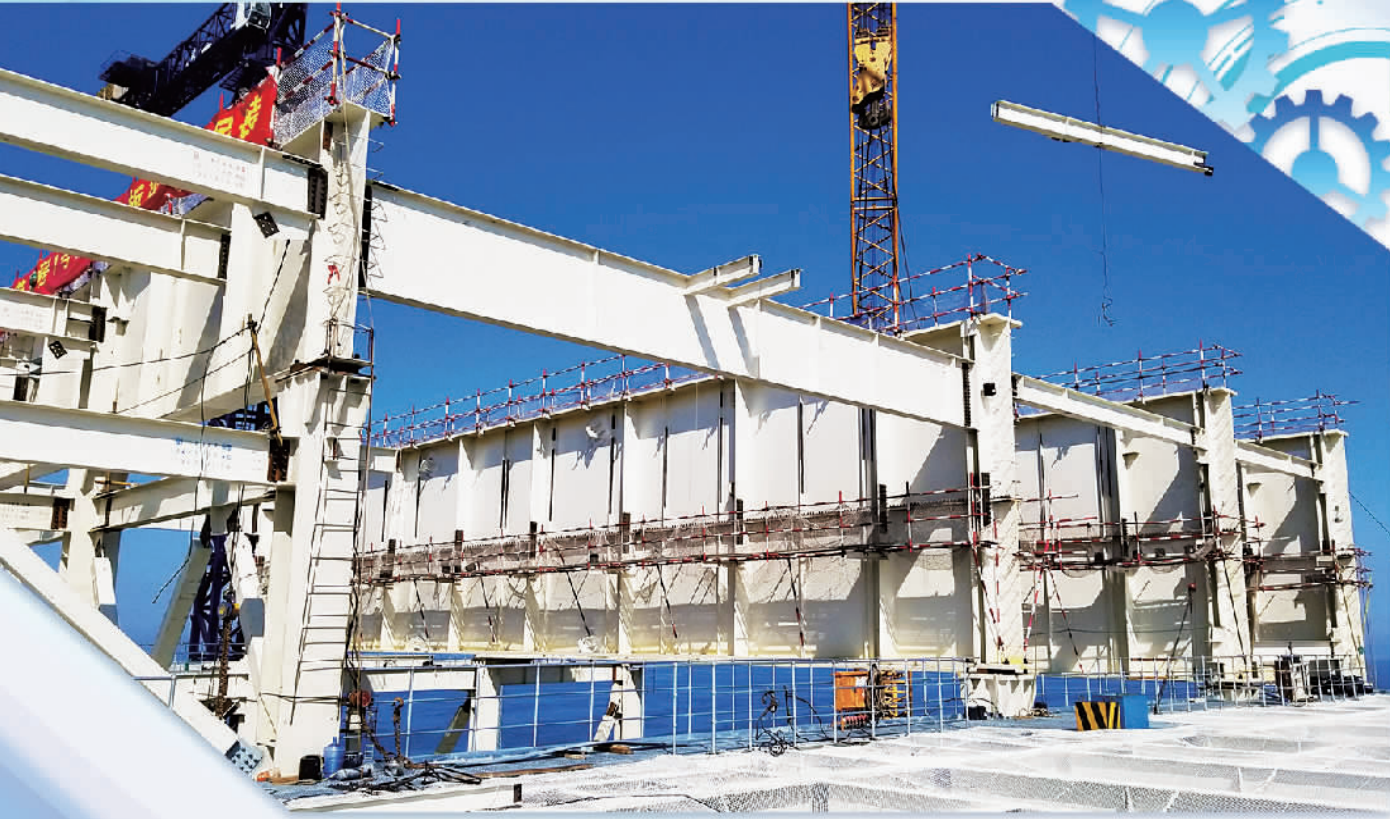
三联公司生产的锅炉大板梁安装现场。
