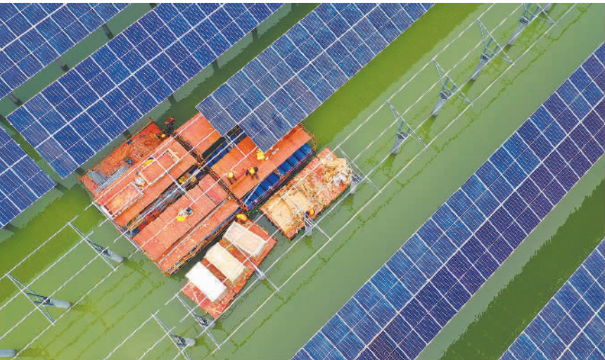
12月12日,浙江省玉环市苔山塘100兆瓦“渔光互补”光伏发电项目施工现场,工人正在安装发电设备。 近年来,玉环市加快“渔光互补”光伏电站建设,带动当地实现经济、生态双丰收。 段俊利摄(中经视觉)
