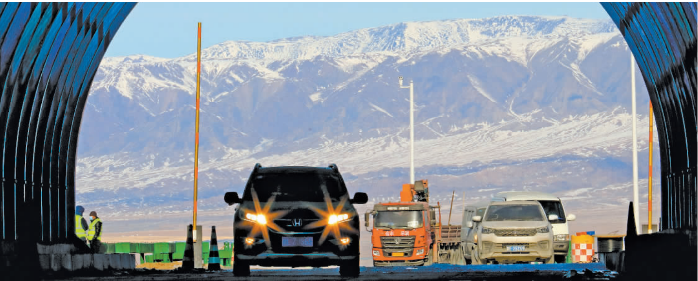
12月4日,新疆哈密市伊州区松树塘,施工车辆有序驶入G575公路东天山特长隧道。该隧道是“一带一路”建设“丝绸之路大通道”及《国家公路网规划》重要组成部分,设计时速80公里,目前建设进入收尾阶段,预计年底通车。通车后从隧道穿越天山南北仅需约9分钟。 蔡增乐摄(中经视觉)
