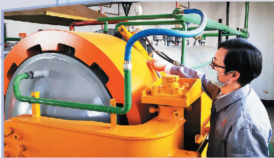
瓷兴技术人员正在调试新增的4000升反应釜。
