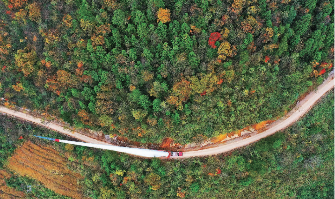
11月20日,运输风电叶扇的卡车行驶在重庆市黔江区濯水镇五福村的山路上。黔江区五福岭风电场位于濯水镇海拔1500多米的五福岭上,由23台风力发电机组组成,装机容量为80MW,总投资6亿多元。为确保今年底建成投用,工人们正加紧施工,确保按质按时建设完工。
