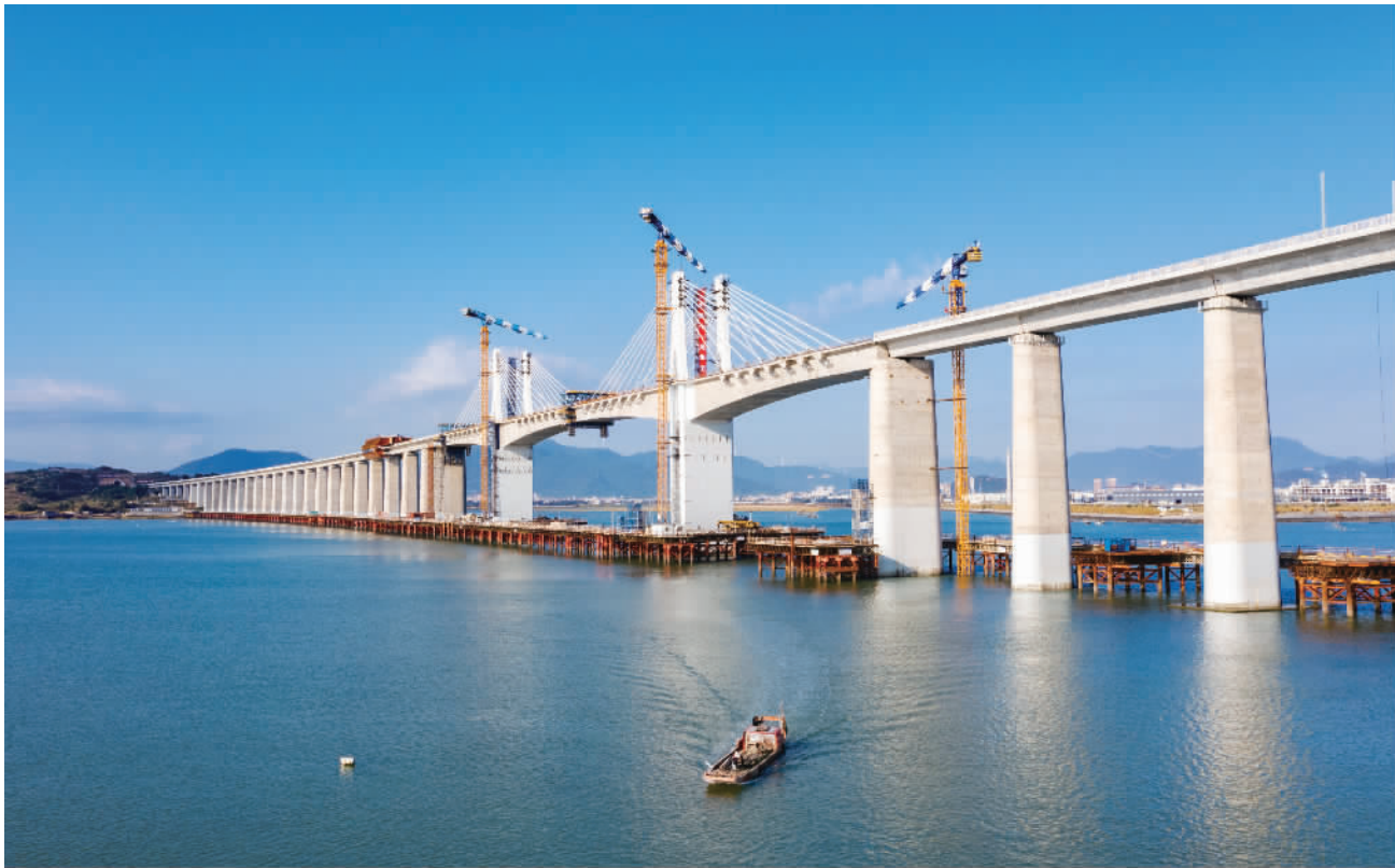
11月13日,由中铁十一局承建的涓洲湾跨海特大桥成功合龙,标志着福厦高铁关键控制性节点顺利打通,为工程如期建成通车打下了坚实的基础。涓洲湾跨海特大桥长14.7公里,海域施工长10.8公里,主桥为预应力混凝土连续刚构矮塔斜拉桥,主跨180米,是国内首座跨海高铁矮塔斜拉桥。
