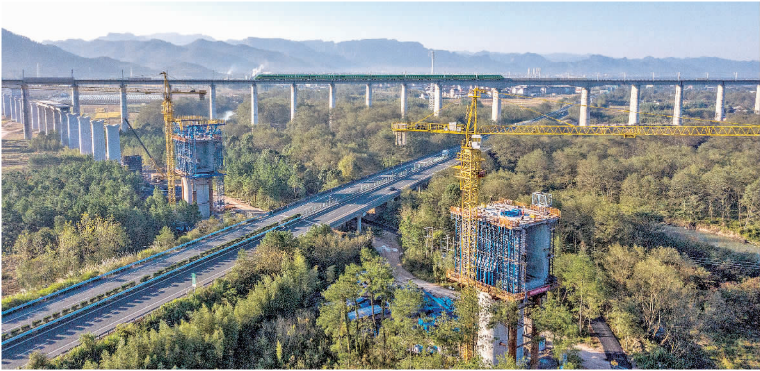
11月10日,杭温铁路浙江省仙居县特大桥施工现场,中铁上海工程局的工人正在进行桥梁上部结构施工。连日来,中铁上海工程局工人利用晴好天气,加班加点奋战在工地上,稳步推进工程建设进度。该大桥是杭温铁路重点控制性工程,桥梁总长4418.33米,共有103个桥墩。(中经视觉)
