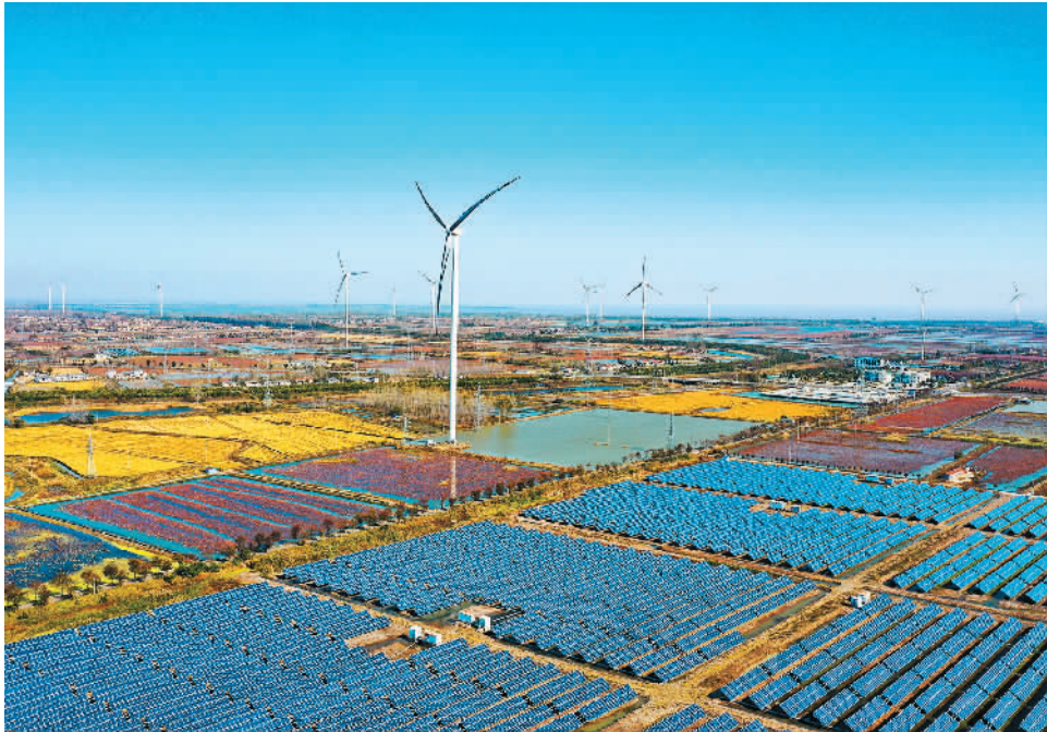
江苏金湖县高邮湖边九洲新能源风力发电站与光伏电站一角。该县利用境内丰富的滩涂资源,科学规划发展新能源。今年1月份至10月份,金湖县风电和光伏发电量突破10亿千瓦时,达到11.4亿千瓦时,相当于节约标准煤38万吨,减少二氧化碳排放102.6万吨。
