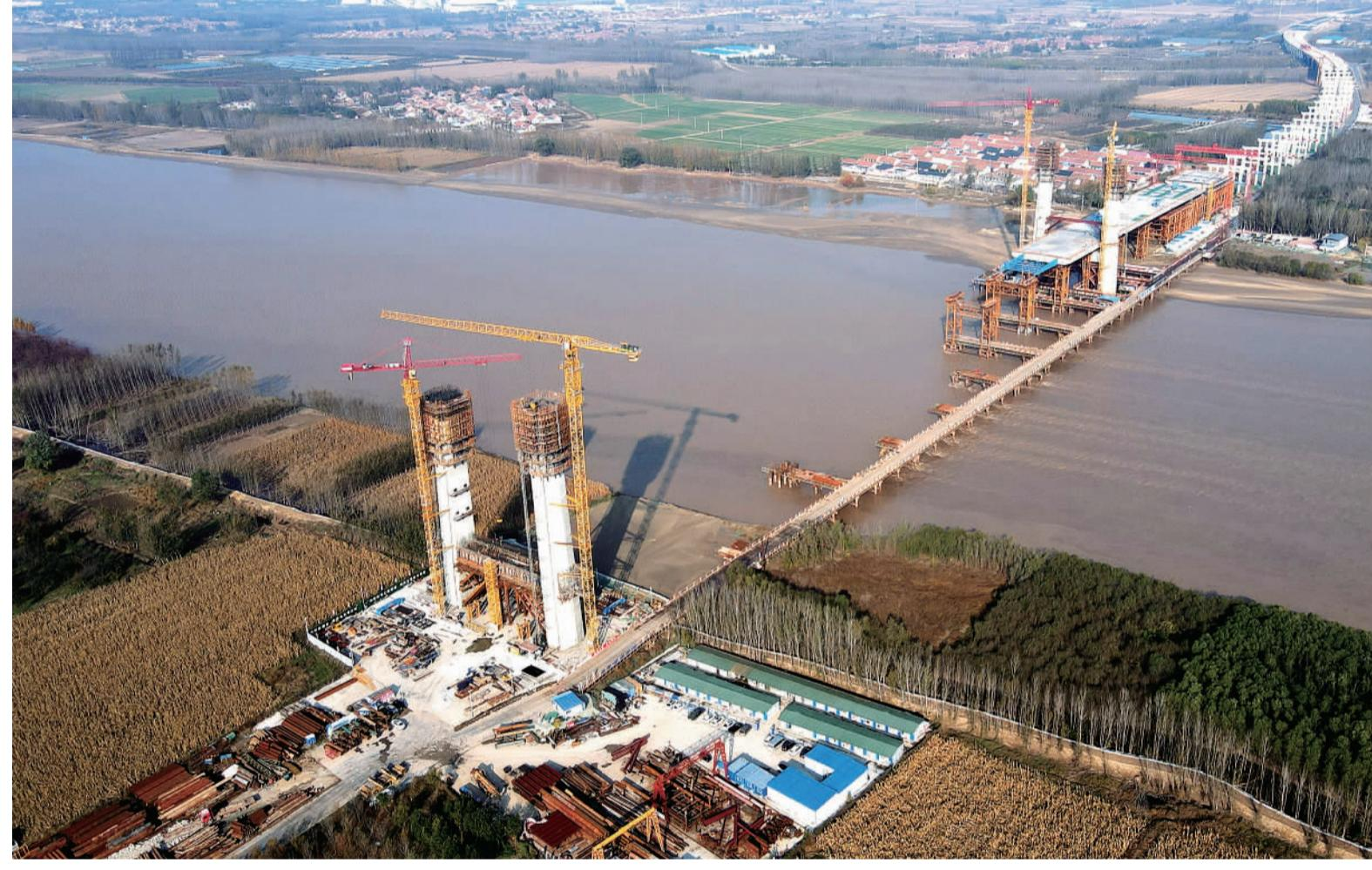
11月1日,山东省滨州市沾临高速公路黄河特大桥施工现场,建设团队正在抢抓工期,加快建设进度。沾临高速公路是山东高速公路网的重要组成部分,主线全长107公里,其中黄河特大桥全长4630米。
