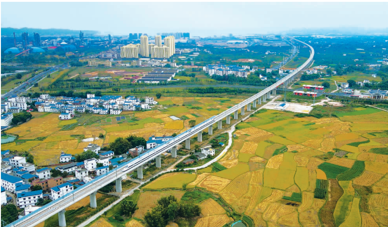
10月28日,赣(州)深(圳)高铁江西段进入运行试验阶段。赣深高铁北起江西赣州,途经信丰县、龙南市、定南县,终至深圳市,正线全长436.37公里,计划12月具备开通条件。通车后,南昌经赣州到深圳旅行时间将缩短至3.5小时。本报记者 赖永峰摄
