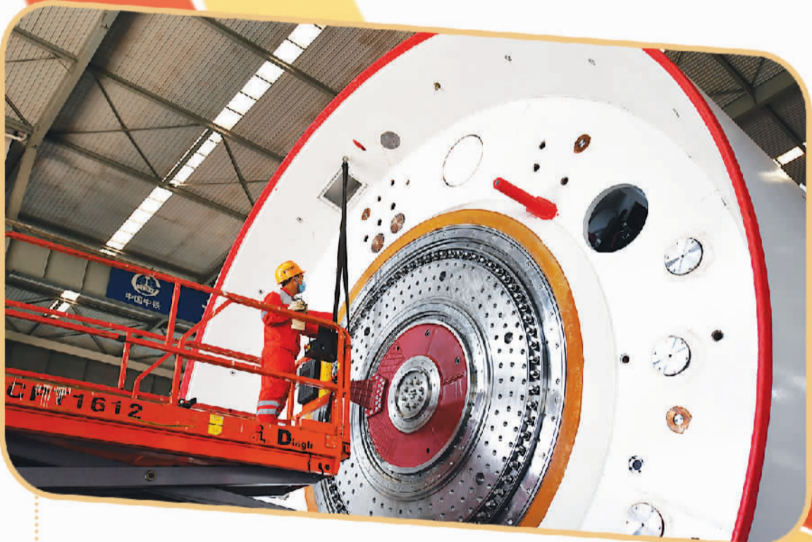
工人在位于河南省郑州市的中铁工程装备集团盾构机总装车间作业。
