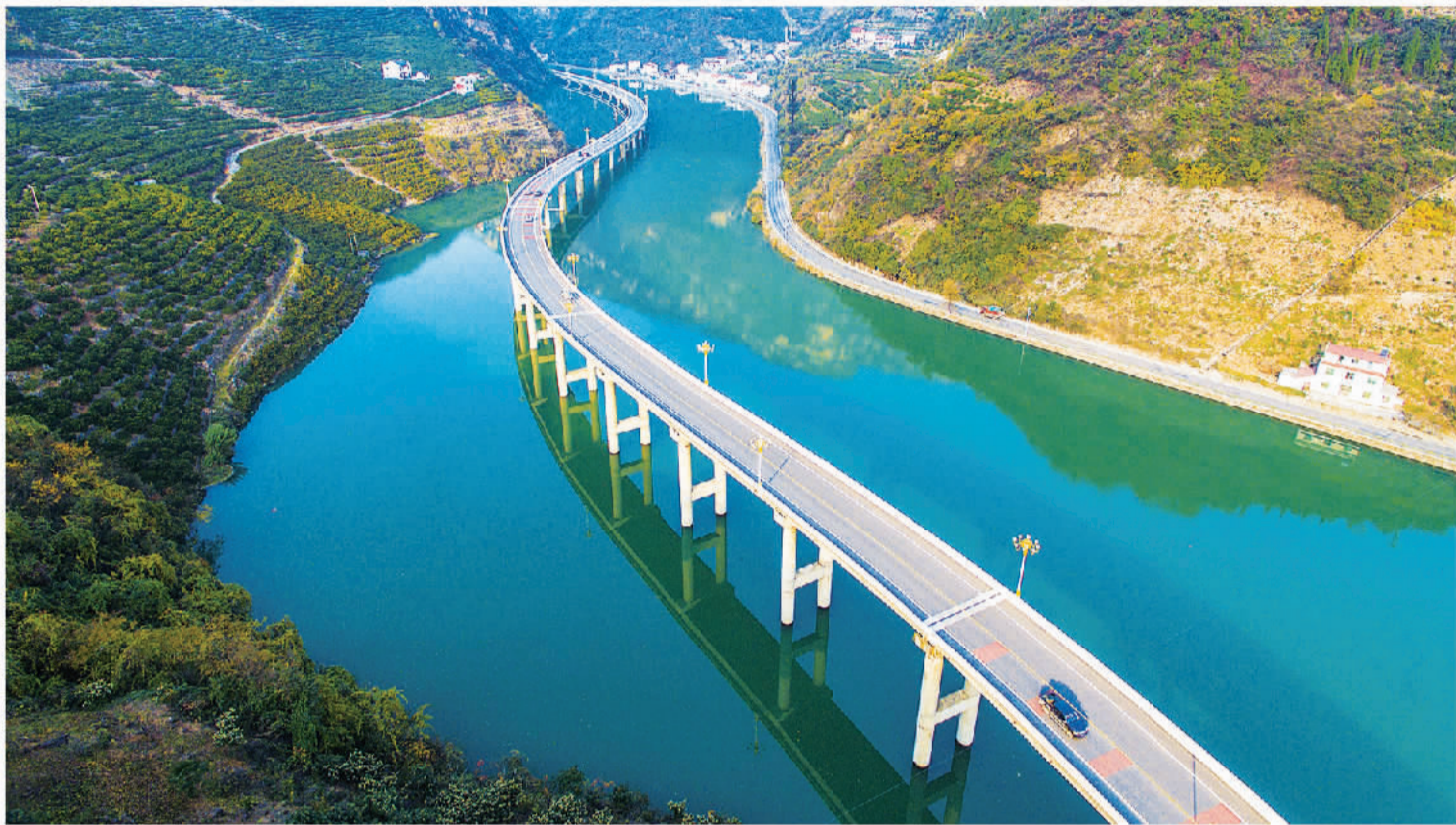
湖北省宜昌市兴山县水上公路(无人机照片)。
