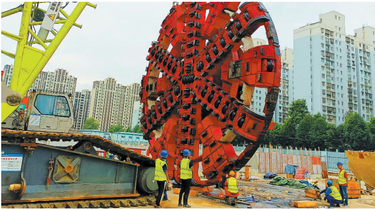
10月19日,“蜀光号”盾构机成功始发,标志着都江堰至四姑娘山山地轨道交通工程正式进入盾构施工阶段。该项目由中铁隧道局施工,是我国首个山地轨道交通扶贫项目,串联都江堰、青城山等景区,有助于推动成渝地区双城经济圈发展,共建巴蜀文化旅游走廊。图为“蜀光号”盾构机在现场重新组装。 任金茂摄(中经视觉)
