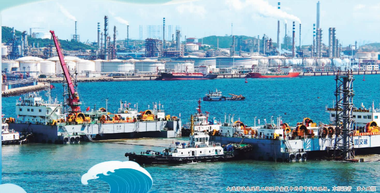
大连湾海底隧道工程沉管安装中的管节浮运现场。本报记者 苏大鹏摄
