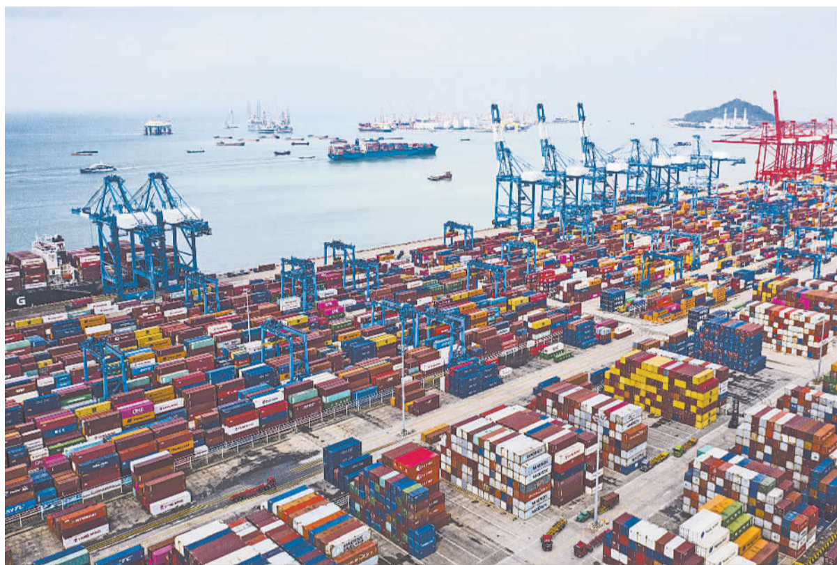
10月14日,深圳妈湾港。改造后的妈湾智慧港占地面积98.36万平方米,泊位岸线总长1930米,共有5个泊位,年设计吞吐量300万标箱,可供靠泊世界最大型集装箱班轮。港口综合作业效率提升30%,巡检效率提升100%,装卸速率提升20%,运营效率提升60%。实现了无人集卡、吊桥远控、智能理货、网联无人机巡检、智慧运营等智慧港口全场景5G应用落地。王美燕摄(中经视觉)
