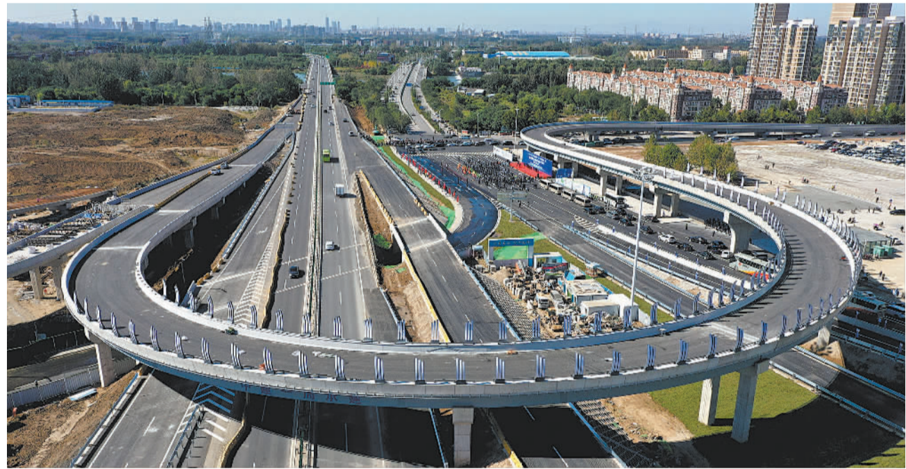
10月12日，京津冀协同交通项目河北三河市通燕高速燕郊出口立交枢纽项目建成通车，形成了“五路汇聚”交通状况。刘 向摄(中经视觉)
