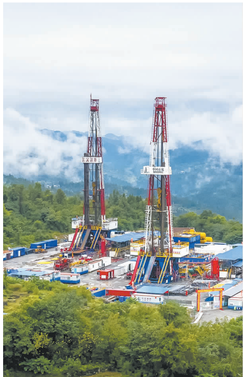
10月8日，我国首个商业开发大型页岩气田——中国石化涪陵页岩气田累计生产页岩气400亿立方米。该气田位于重庆涪陵区，是川气东送管道重要气源之一。图为涪陵页岩气田钻井“井工厂”施工平台。向 阳摄(中经视觉)
