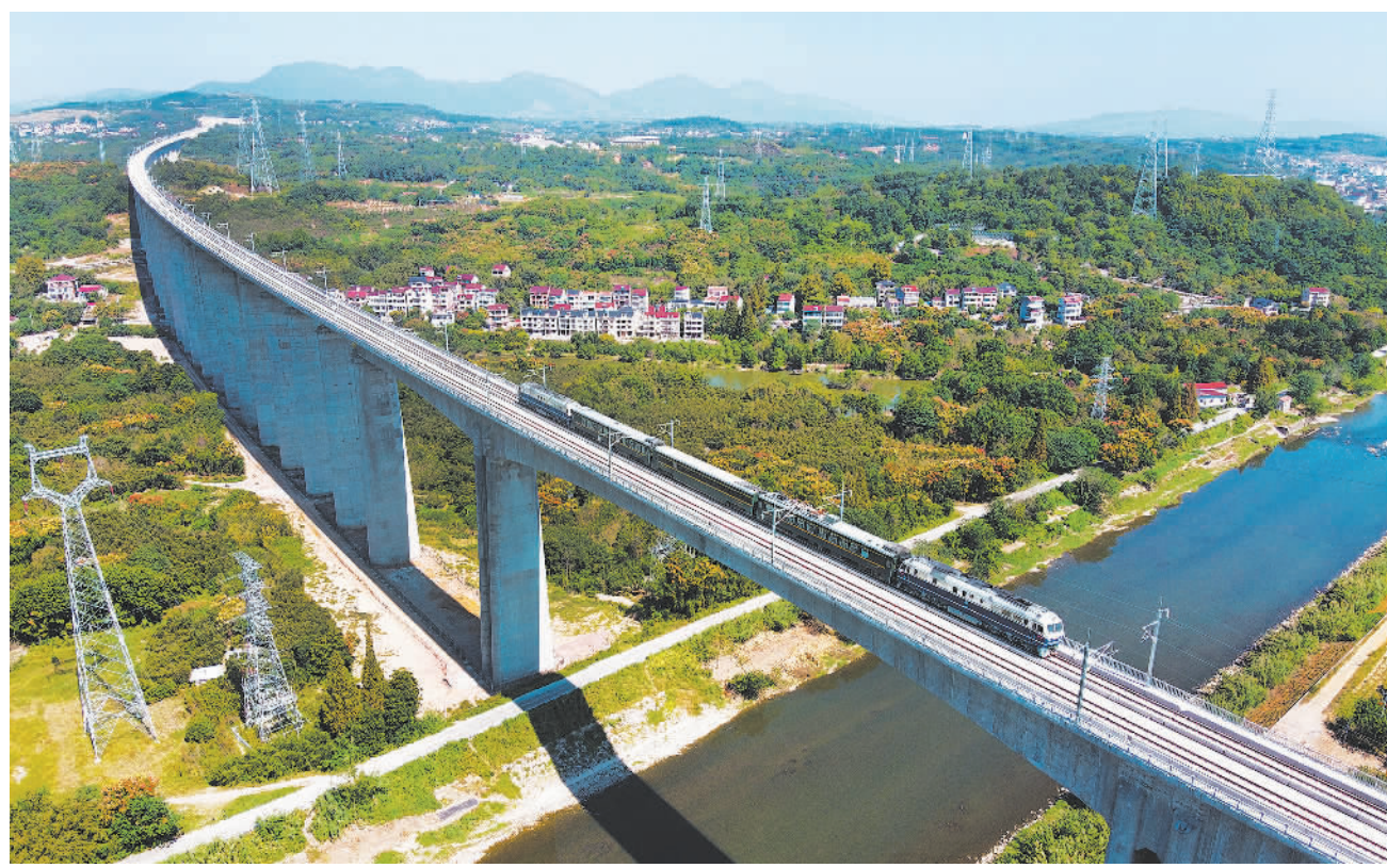
9月27日,检测列车行驶在杭绍台铁路嵊州特大桥上。当日,我国首条民营资本控股高铁——杭绍台高铁开始动态联调联试。该高铁连接浙江杭州、绍兴、台州三地,设计时速350公里。焦宏涛摄(中经视觉)
