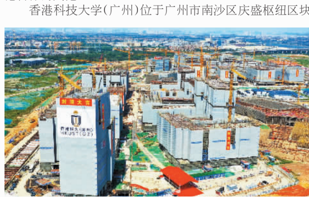
9月26日，香港科技大学(广州)项目一期工程核心建筑和配套建筑主体结构迎来全面封顶
