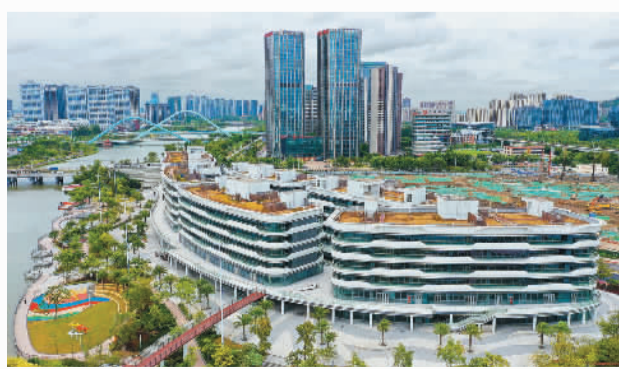
已竣工的创享湾项目
