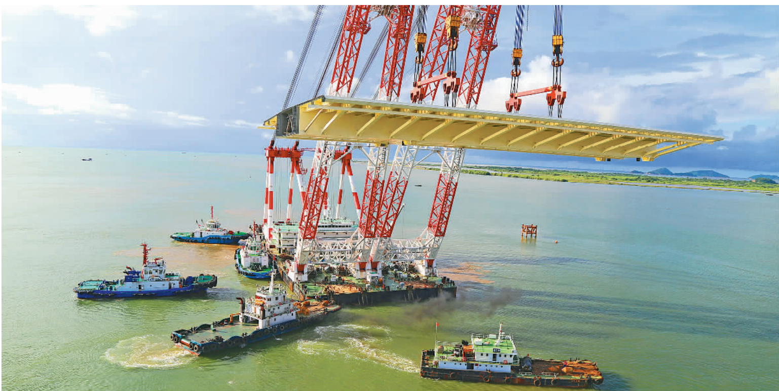
架梁最重。九月份，落界梁广东珠顺利完孟庆虎摄（中经视觉）
