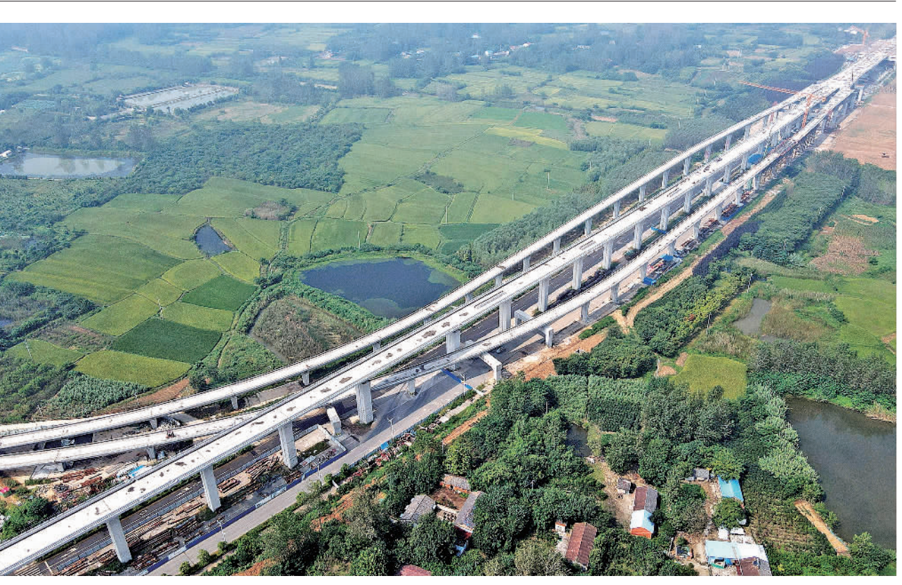
8月30日拍摄的施工中的滁宁城际铁路一期工程(无人机照片)。当日，由中国中铁总承包部承建的滁宁城际铁路一期工程全线最后一孔现浇梁浇筑完成，为后续铺轨等工程施工奠定基础。滁宁城际铁路西起安徽滁州站，止于正在规划建设中的南京北站，全长约54.4公里。
