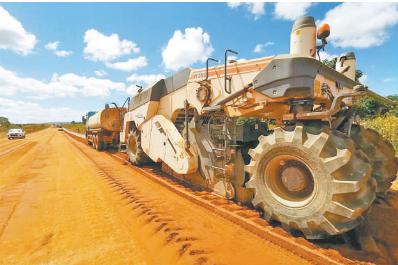
图为中建集团承建的赞比亚103公里道路升级改造项施工现场。(资料图片)
