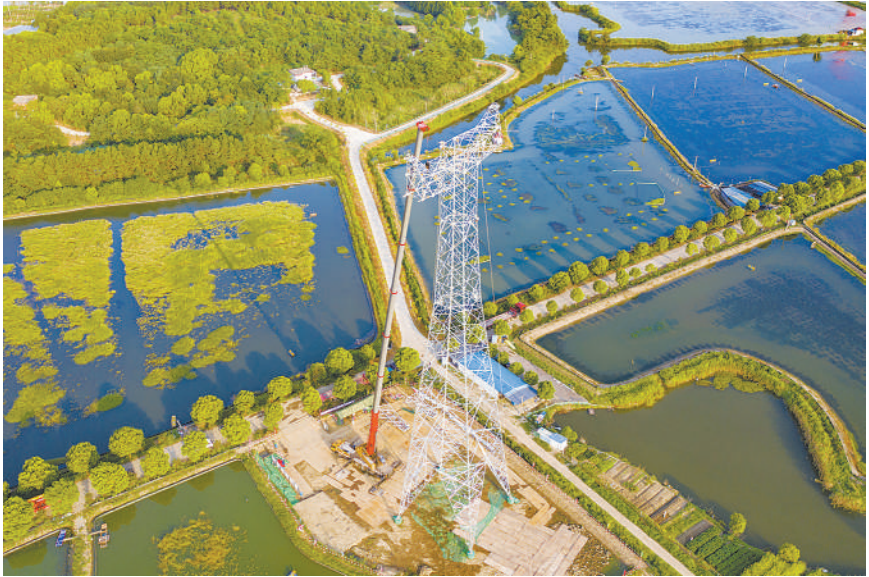
7月22日,位于安徽当涂县的白鹤滩至江苏±800千伏特高压直流输电工程皖4标段,施工人员在70米高空中进行首座铁塔的组立作业。白鹤滩至江苏±800千伏特高压直流输电工程是我国实施“西电东送”战略的国家重大工程,起于四川凉山州布拖换流站,止于江苏苏州虞山换流站,计划于2022年建成投运。 张远溪摄(中经视觉)
