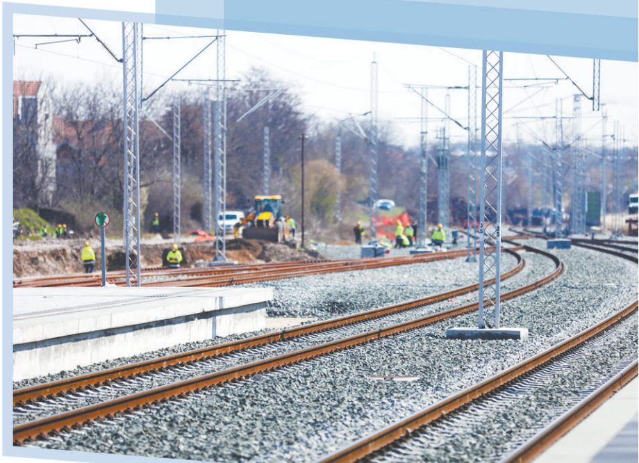
上图 塞尔维亚贝尔格莱德,匈塞铁路项目正在施工。(新华社发)
