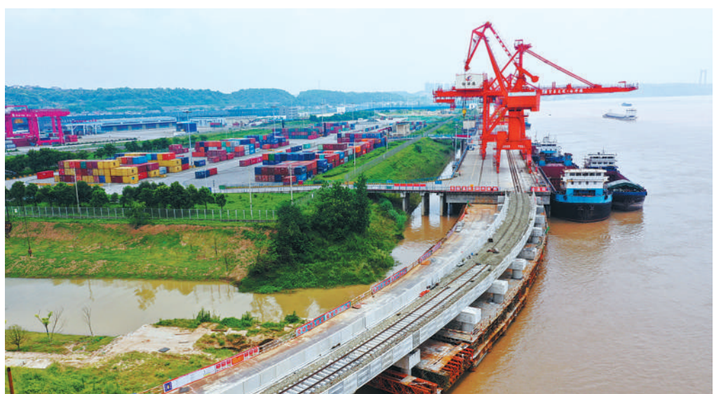
7月16日,三峡枢纽宜昌白洋港正在铺设轨道,这是国内首条引入码头平台的集装箱新型铁路。白洋港主体工程计划今年底完工试运行,可实现铁水无缝对接。 刘卫东摄(中经视觉)
