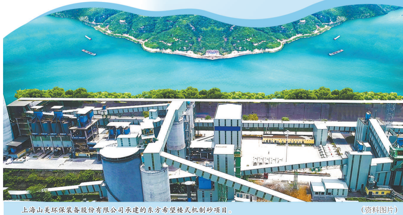
上海山美环保装备股份有限公司承建的东方希望模式机制砂项目。
