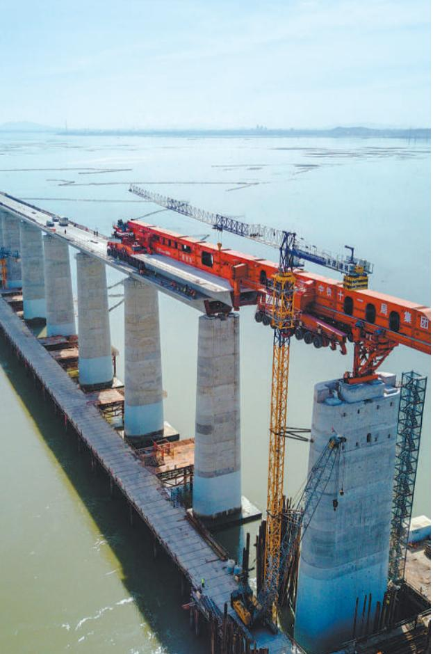
7月11日,在新建福厦铁路湄洲湾跨海大桥建设现场,“昆仑号”在架设该线路最后一孔40米箱梁。“昆仑号”是目前世界唯一的千吨级运架一体机,自2020年首次在新建福厦铁路湄洲湾跨海大桥建设现场亮相以来,共架设40米高铁箱梁298孔。接下来,这台体现我国高铁桥梁架设最先进技术的大国重器将参与杭衢铁路的建设。新华社记者 宋伟摄
