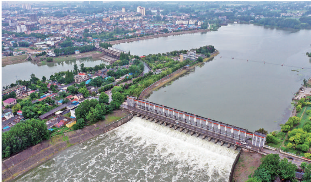
7月7日，位于安徽蒙城县城区的涡河蒙城闸正在开闸放水。当日上午11时许，涡河蒙城节制闸20孔闸门开度由0.4米调整至0.6米，以加大下泄量，腾出库容，及时应对上游来水及区域降雨带来的防汛压力。
