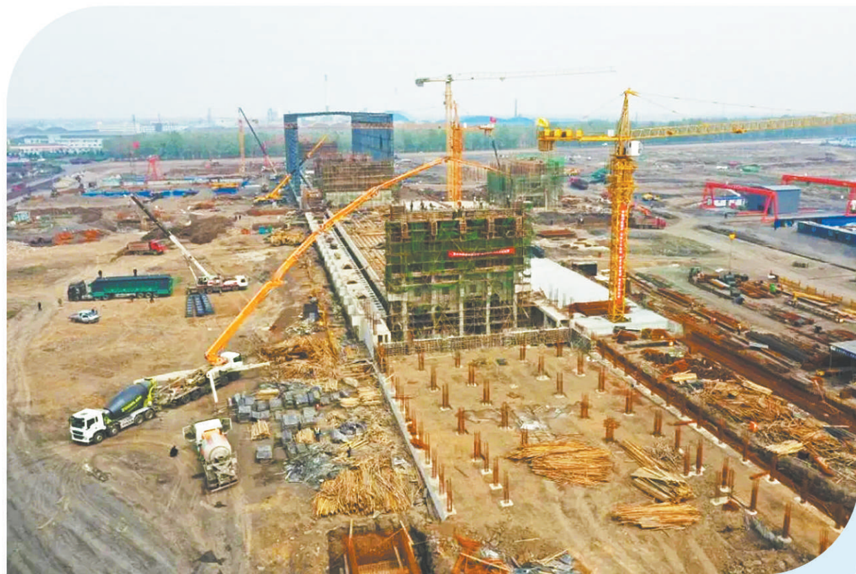
晋中介休市昌盛煤气化公司180万吨/年焦化项目未批先建。
