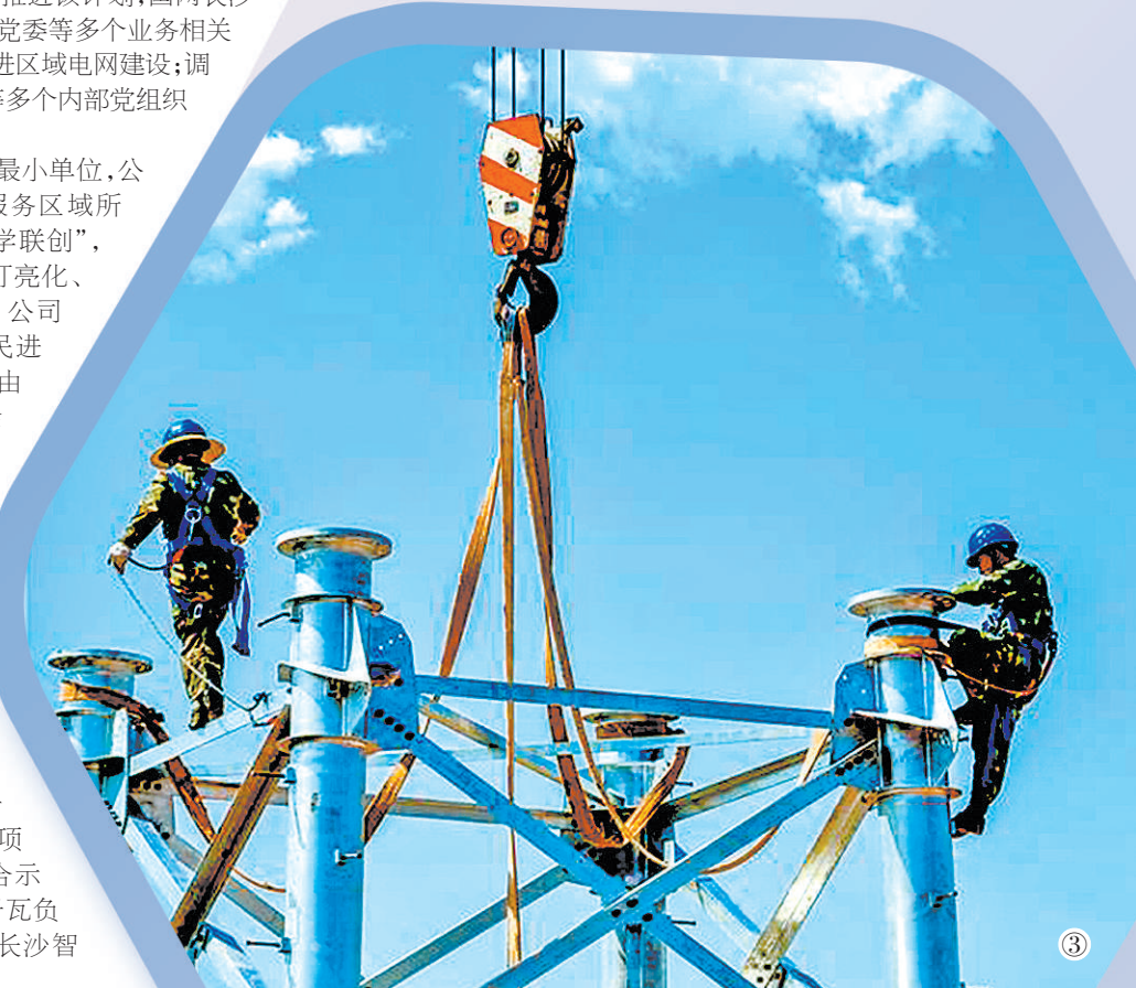
图③ 国网长沙供电公司员工在烈日下进行220kV沙洋线组塔施工。
