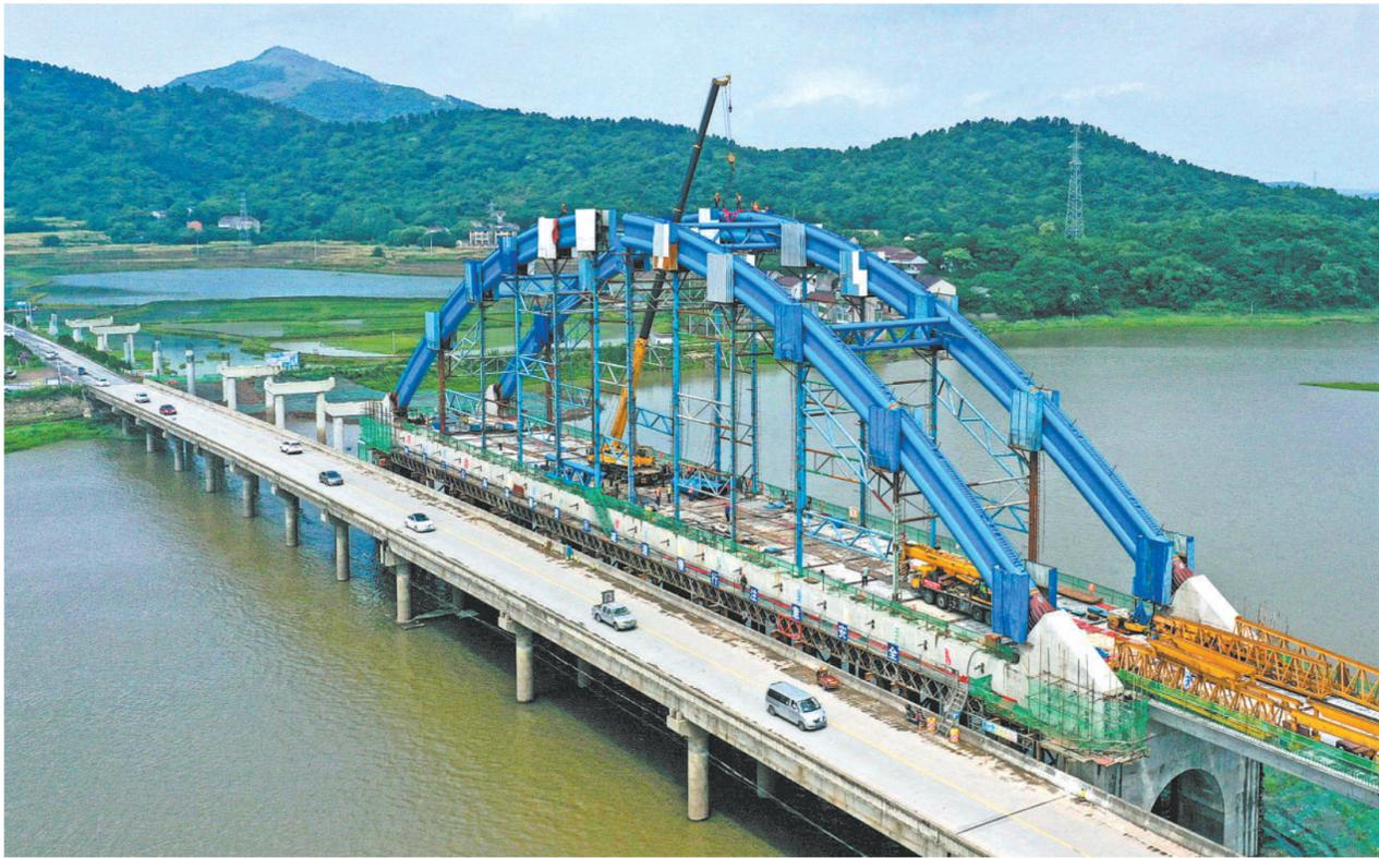
5月14日，位于安徽铜陵市320省道的乌金渡大桥拱合龙作业现场，中铁第三公路工程局施工人员在吊装最后一段拱拱。
