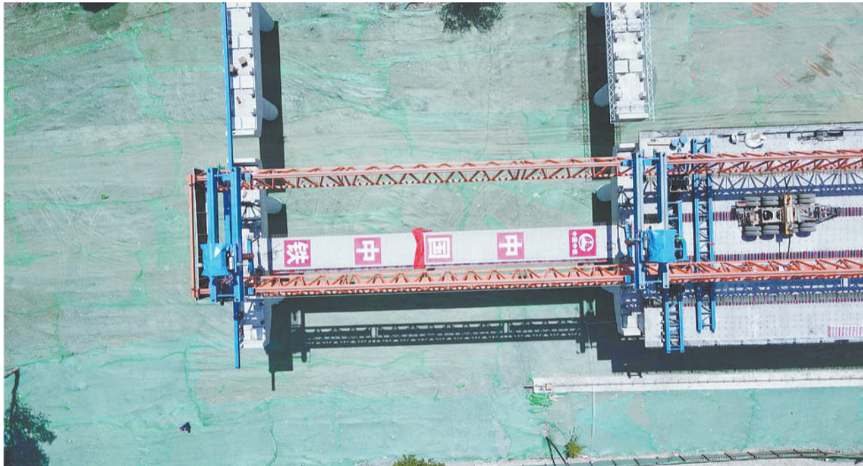
5月10日,由中铁十局承建的国道109新线高速公路项目响特大桥成功架设全线首根箱梁。国道109新线高速公路是北京门头沟首条高速,也是北京市投资额最高的单体山区高速公路项目,计划于2023年底建成通车。 郑世平摄(中经视觉)
