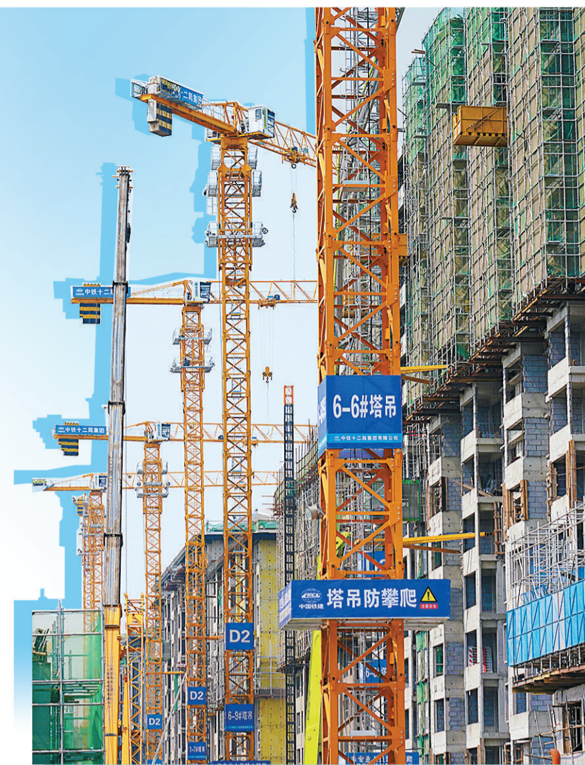
4月8日拍摄的雄安新区容东片区安置房项目建设现场。
