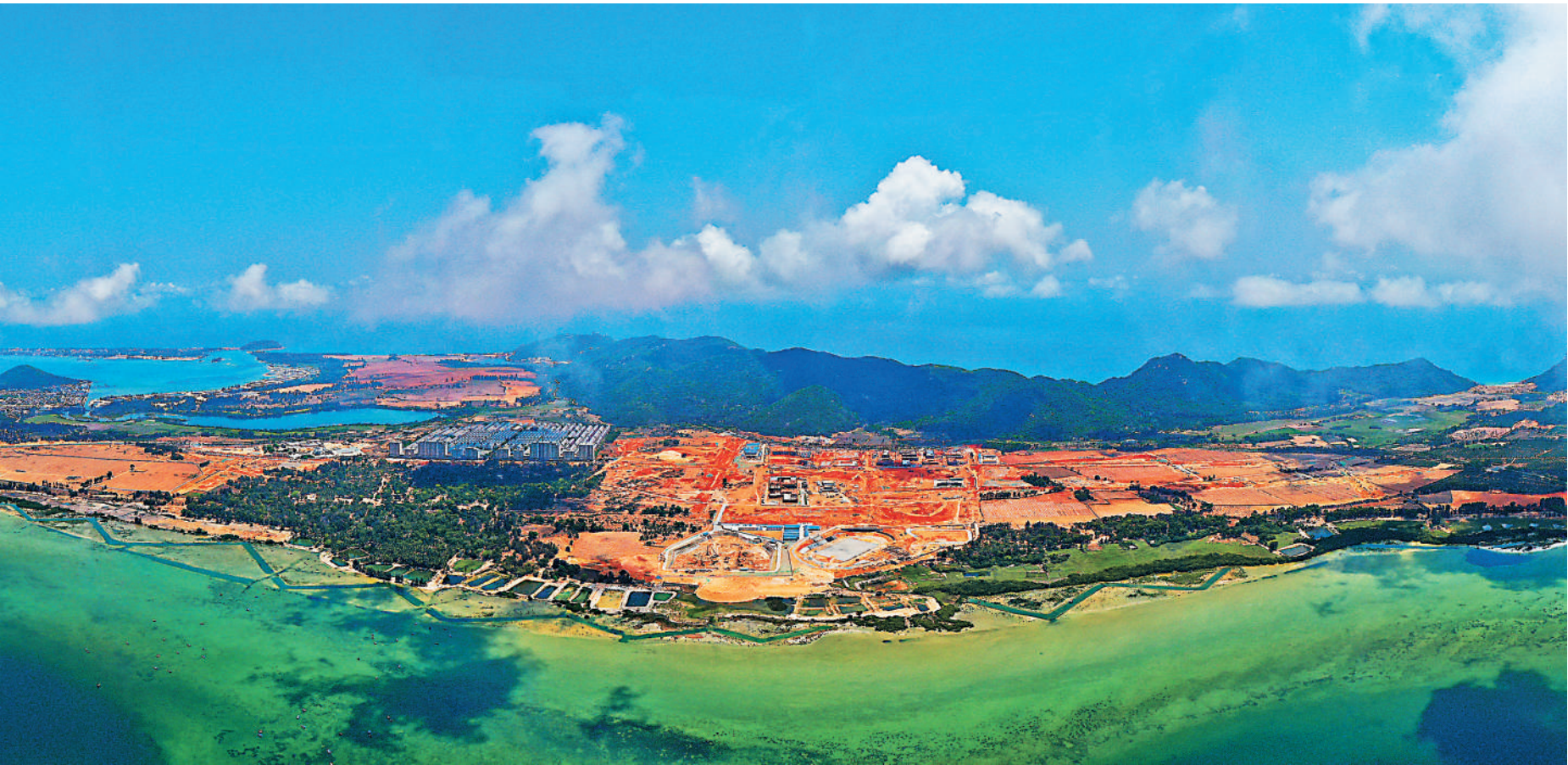
正在建设中的海南自由贸易港陵水黎安国际教育创新试验区(4月4日摄,无人机照片)。海南自由贸易港陵水黎安国际教育创新试验区位于海南省陵水黎族自治县黎安半岛,规划面积12.72平方公里,于2020年9月开工建设。目前已引进中国传媒大学、北京体育大学、英国考文垂大学等16所中外高校。
