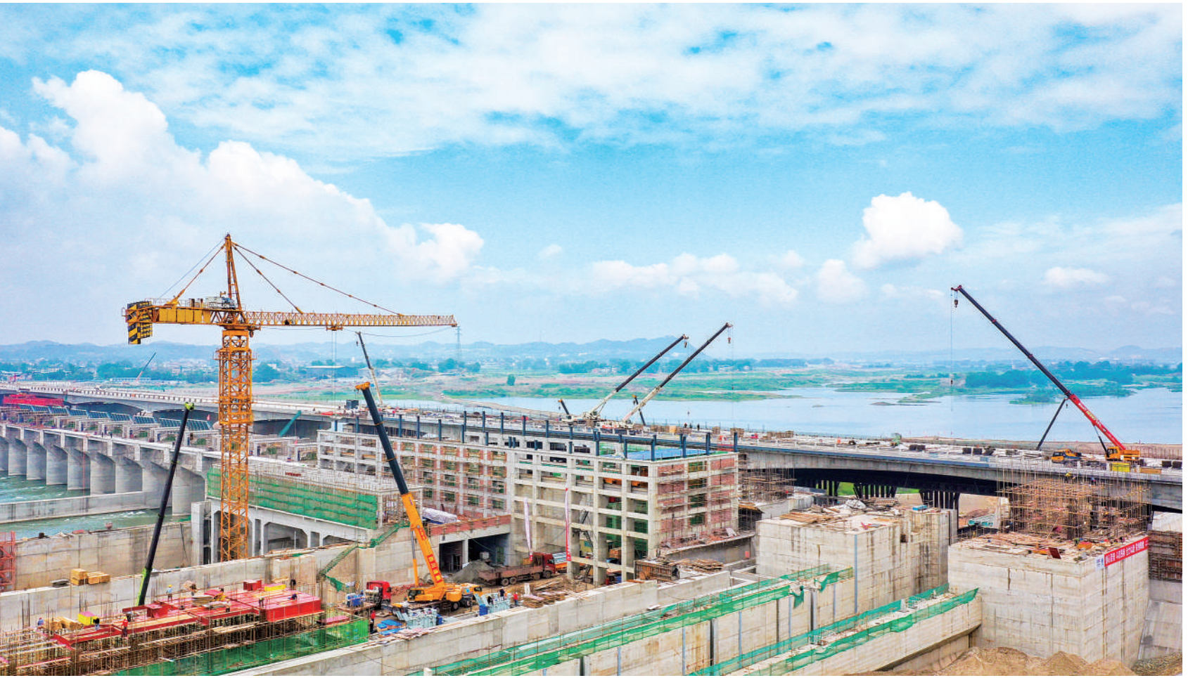
4月12日,四川省遂宁市唐家渡电航暨风台大桥施工现场一派忙碌。作为四川省重点建设工程,该项目是遂宁跨越涪江连接风台新区和河东二期的重要通道。目前,大桥主体工程全面完成,已实现合龙,整个工程完成总投资的90%以上,大桥预计5月底具备通车条件。 刘昌松摄(中经视觉)
