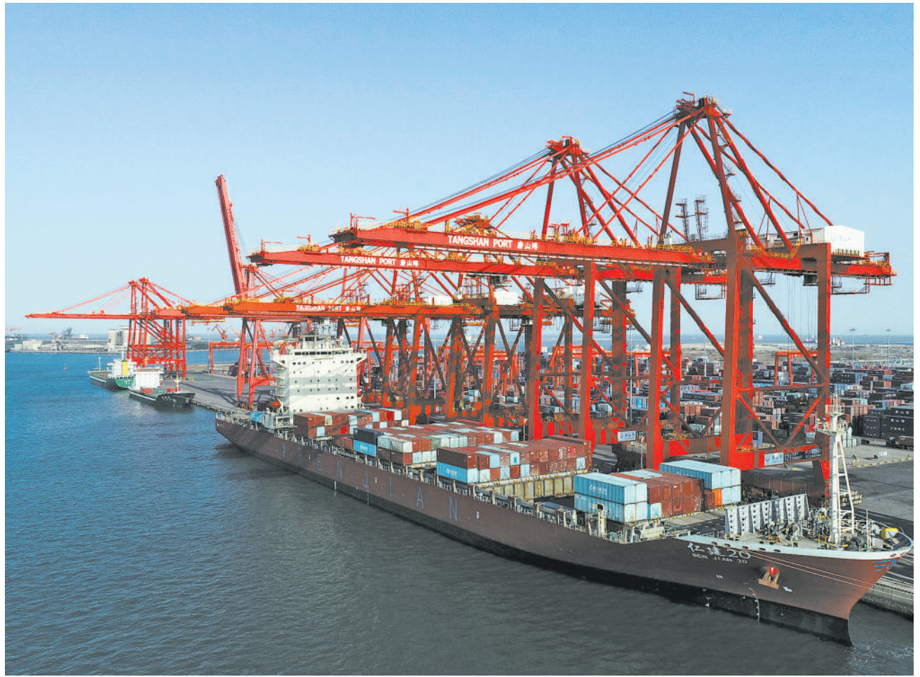
4月8日，轮船靠泊在河北省唐山港京唐港区集装箱码头进行装船作业。今年一季度，唐山港完成货物吞吐量17412万吨，同比增长22.93%。在受疫情影响的不利形势下，增长数据创下历史同期最高水平，进一步巩固了唐山港服务重大国家战略的能源原材料主枢纽港地位。李 磊摄(中经视觉)
