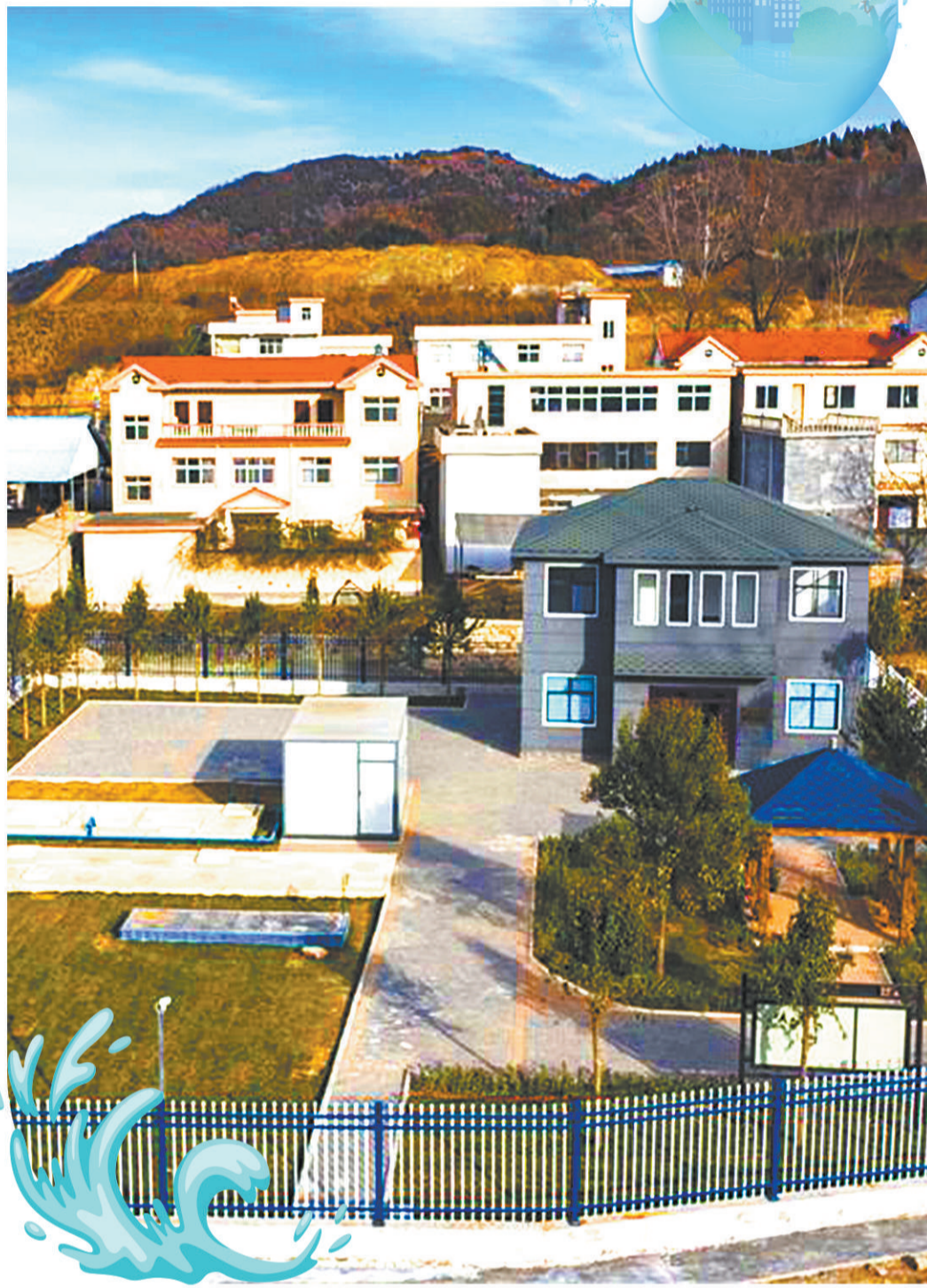
图为养子沟污水处理站。
