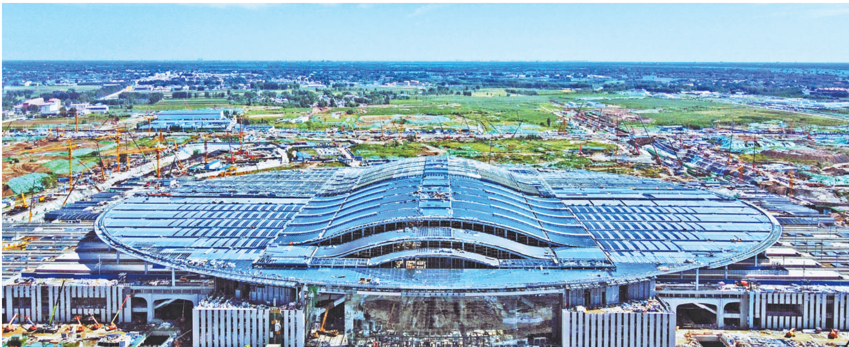
京雄城际铁路是京津冀协同发展国家战略的重要交通支撑,是京津冀城际交通网的重要组成部分。2020年12月27日,京雄城际铁路实现全线开通运营。图为俯瞰京雄城际铁路雄安站。
