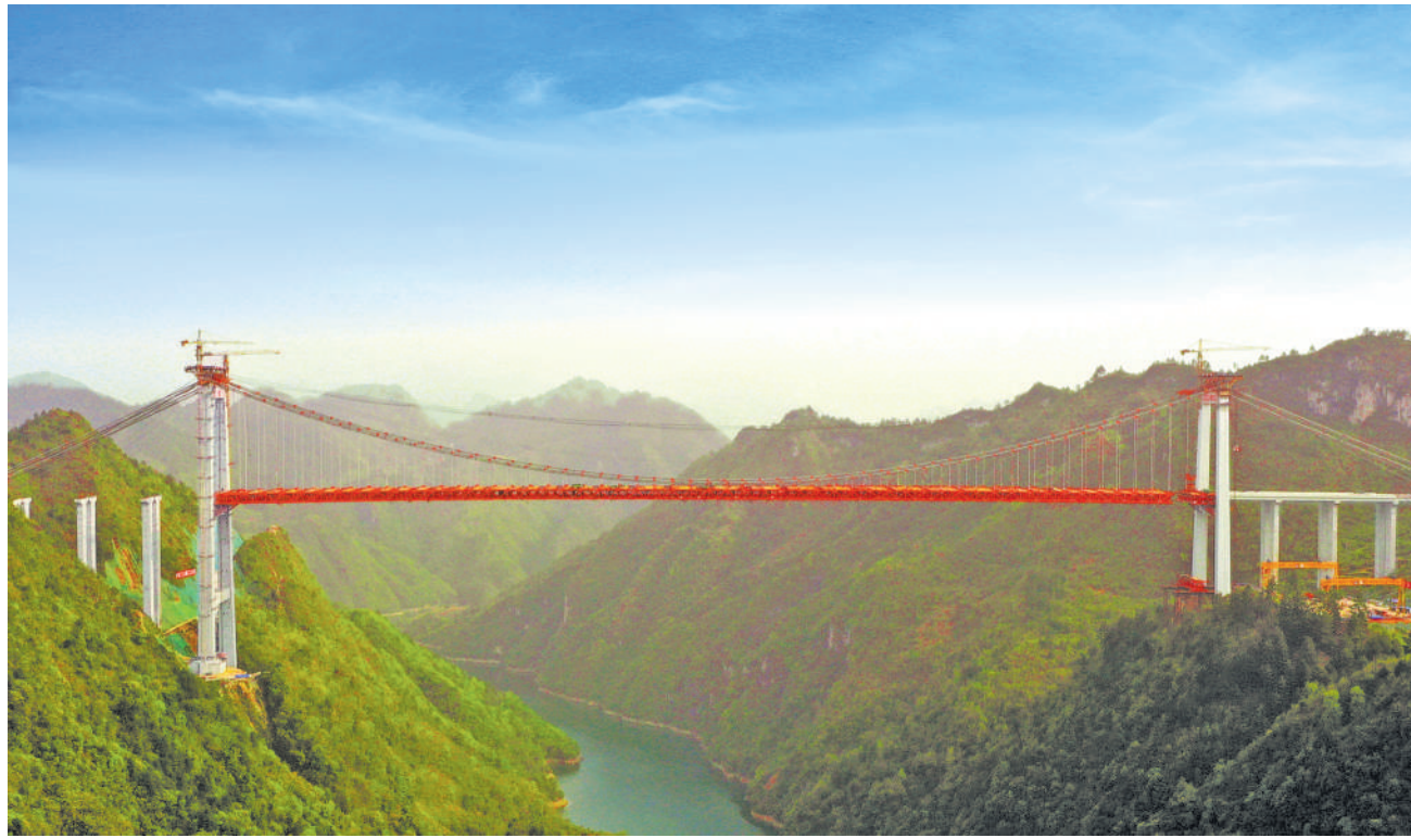
3月27日,由中交二公局二公司承建的贵黄高速公路阳宝山特大桥主桥钢桁梁顺利合龙。 阳宝山特大桥位于贵州省黔南布依族苗族自治州贵定县新巴镇和德新镇,大桥全长1112米,主跨650米,为单跨钢桁梁悬索桥,是贵黄高速公路控制性工程。 董晨曦摄(中经视觉)
