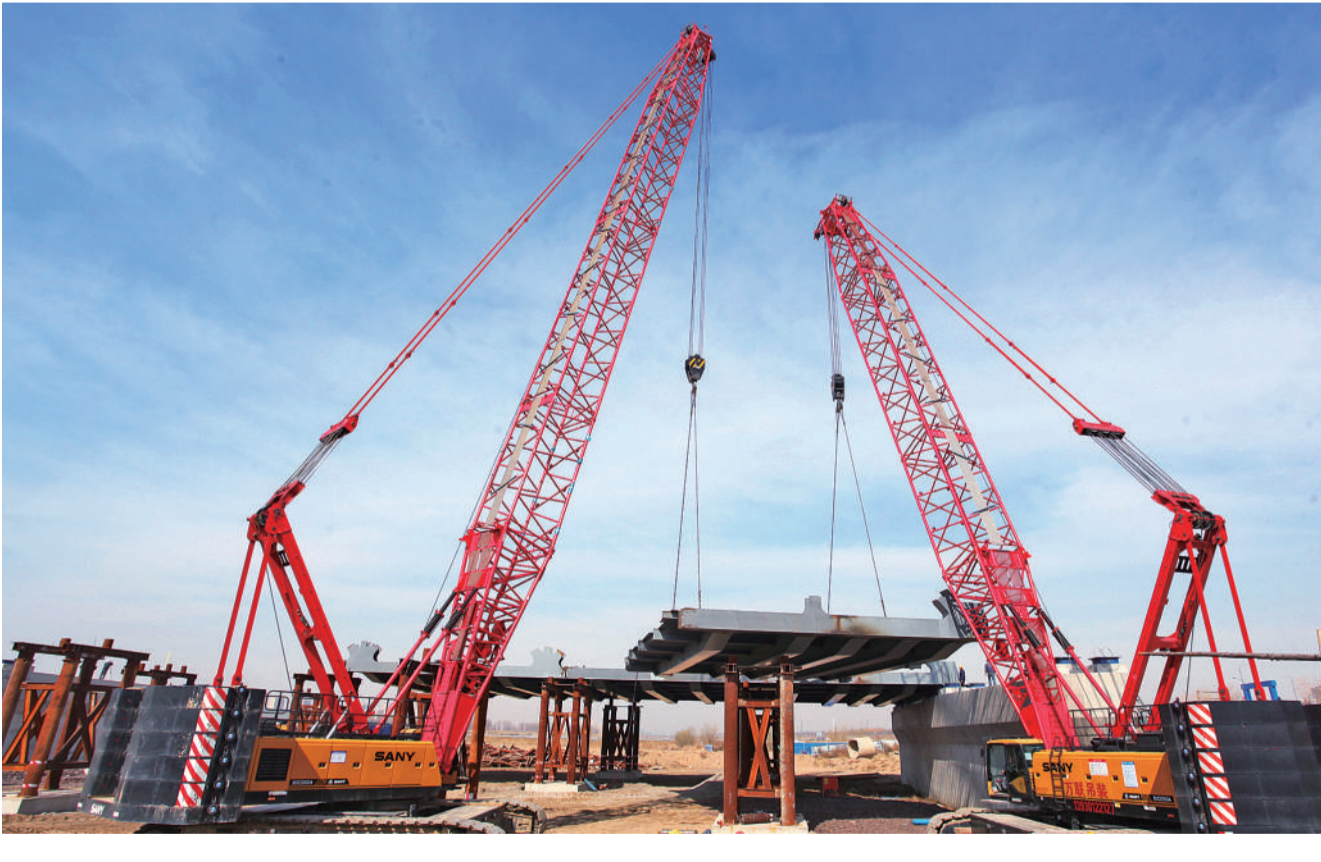
3月24日,河北省张家口市宣化区跨洋河河道胜利桥工程在建设中。该工程将于年内建成,届时宣化区自东向西将形成胜利桥、洋河一桥、洋河二桥、柳川西路桥、四江桥“五桥”横跨洋河联通两岸的交通格局,带动城乡融合发展,同时推进洋河生态恢复和治理。 陈晓东摄(中经视觉)
