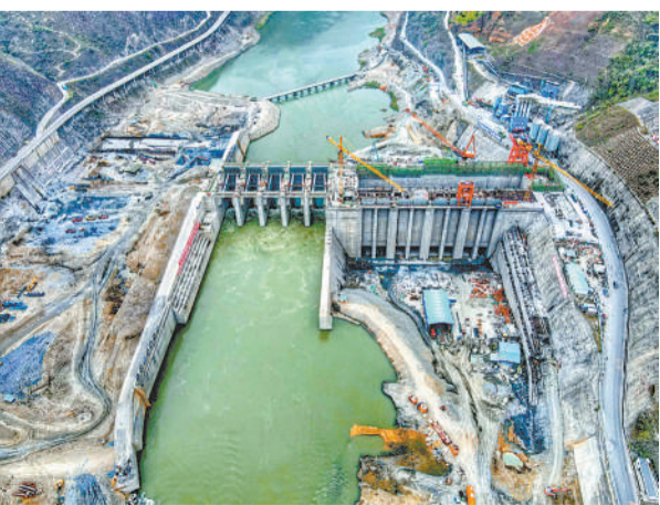
图为建设中的陕西旬阳水电站。该水电站由中国电建水电十局承建,是汉江干流上以发电为主、兼顾航运的水电枢纽工程。
