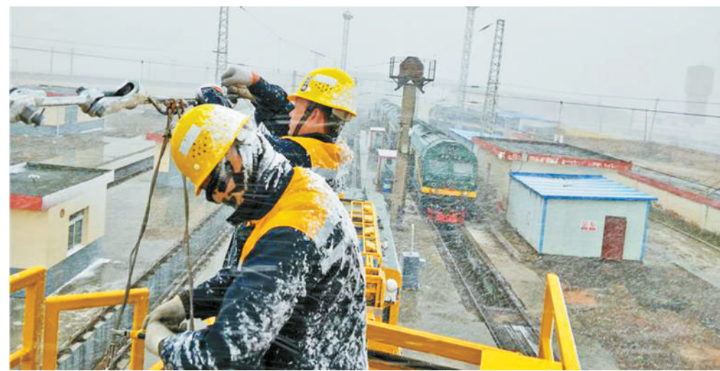
青藏集团公司西宁供电段哈尔盖接触网工区职工冒雪工作。
