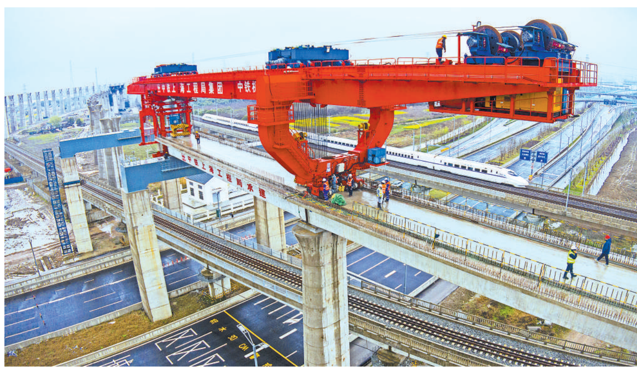
3月19日,南沿江城际铁路太仓至安亭上行联络线特大桥,一孔32m单线箱梁平稳安放在桥墩上,标志着江苏太仓梁场上跨太仓通沪场工区维修线的3孔箱梁架梁架线施工顺利完成,也拉开了太仓梁场南沿江城际铁路营业线施工的帷幕,为后续的上跨沪苏通铁路和工区箱梁架梁架线施工奠定了基础。
