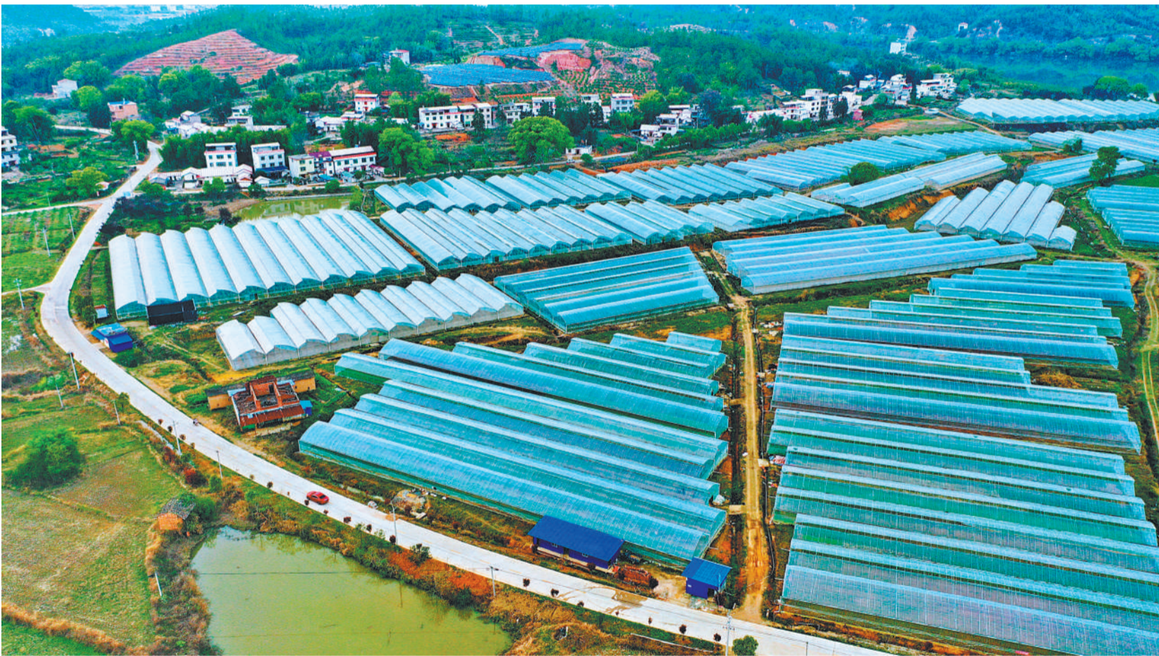
3月14日,江西省赣州市会昌县珠兰乡上照村,新建的公路通到了村里。近年来,会昌县积极实施“交通扶贫+产业振兴”工程,新建农村公路2200公里,为乡村振兴提供了良好的交通基础设施。朱海鹏摄(中经视觉)
