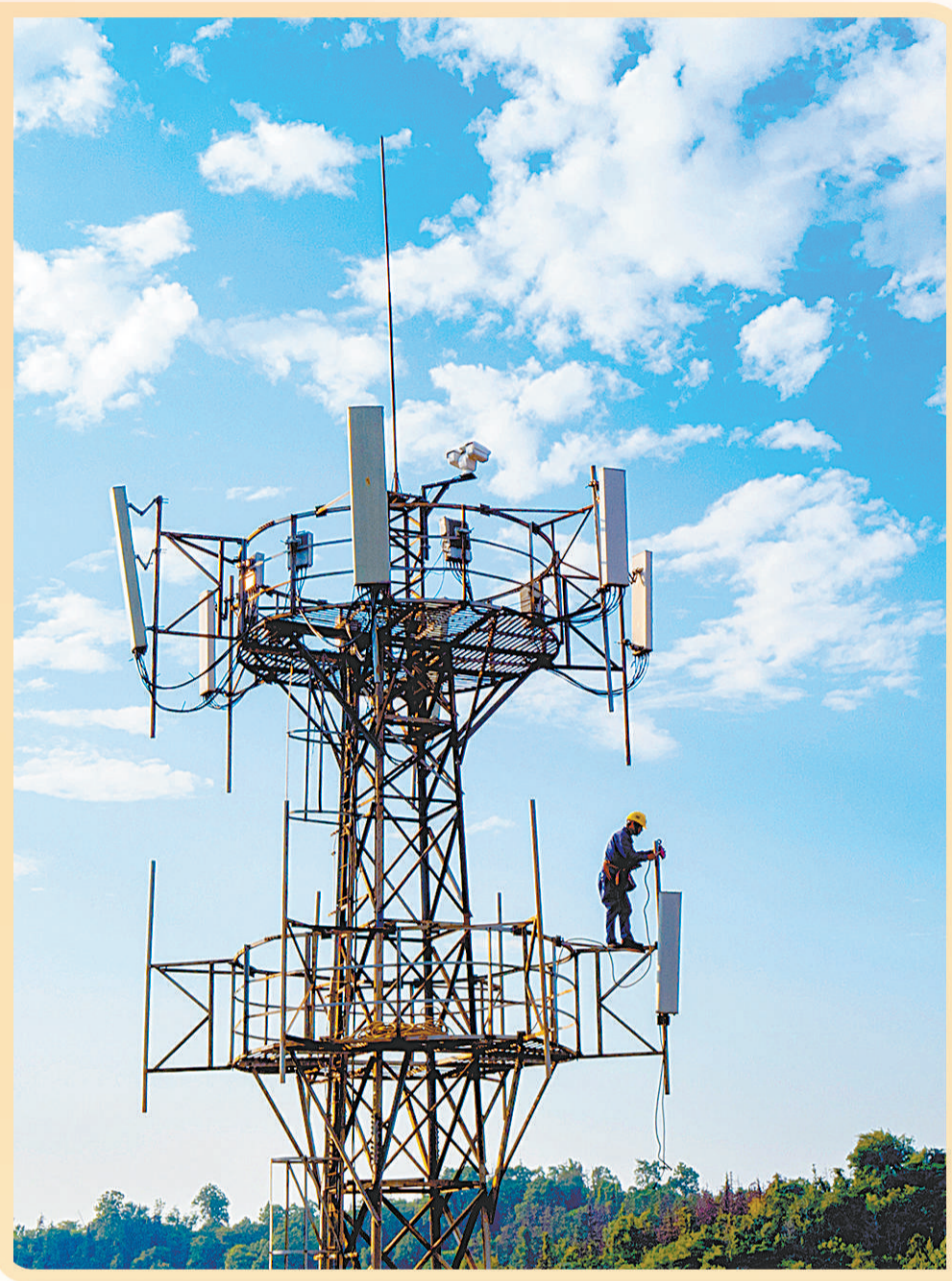
截至目前，江西已实现全省所有城市主城区5G网络连续覆盖。图为江西湖口县5G基站建设施工现场。
