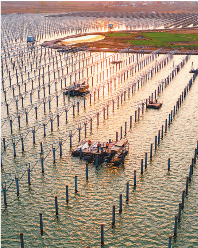
2月23日,安徽省合肥市肥东县杨店乡大李水库渔光互补光伏电站项目施工现场一派繁忙,工人在浮船上安装光伏板支架。(阮雪枫摄(中经视觉))
