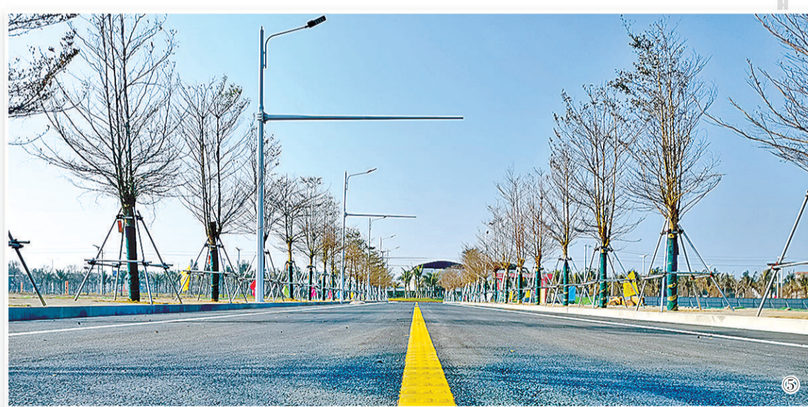
图① 和若铁路建设现场。图② 在津静线静海区国际医学城施工现场,施工人员进行钻探桩洞。图③ 信悟高速施工现场。图④ 中铁一局集团有限公司京德高速项目施工人员正制作桥涵钢梁。图⑤ 江东新区起步区路网项目(一期)基本完工路段。
