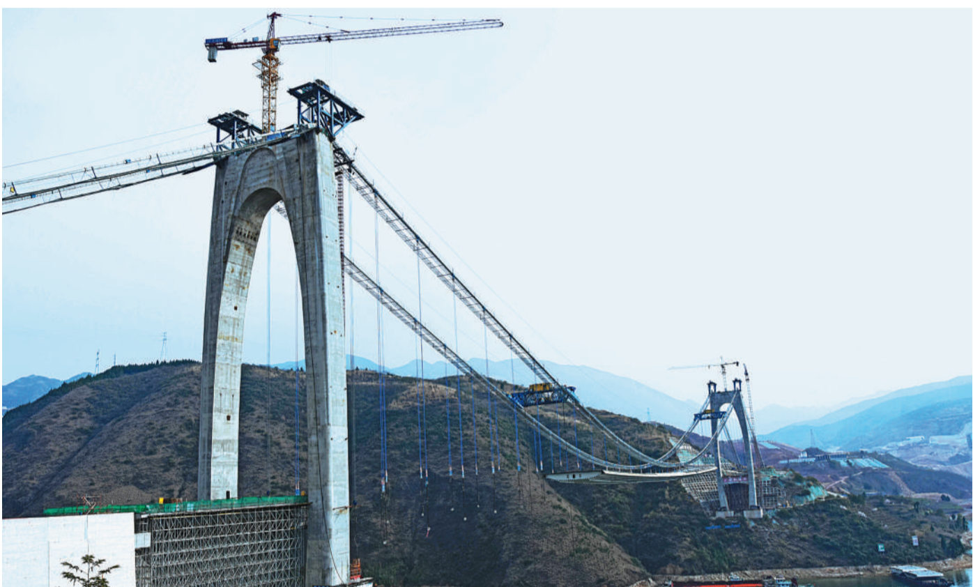
2月18日,重庆巫山桂花大桥正在加紧建设中。该桥位于长江支流大宁河上,属三峡移民后续工作规划重点交通建设项目,是连接巫山高铁站、巫山县城和巫山机场的重要通道。大桥全长1540米,主桥为主跨550米的双塔钢箱梁悬索桥,双向四车道,预计今年10月竣工。
