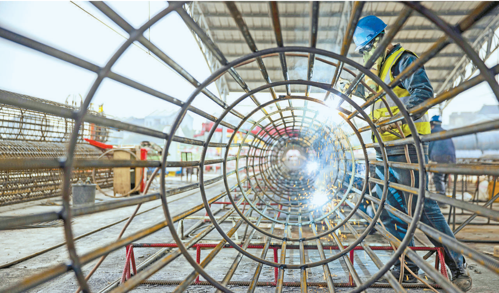
1月27日,在江苏省凤城至梅里500千伏线路长江大跨越工程南岸跨越铁塔建设现场,江苏省送变电有限公司施工人员正进行钢筋笼焊接施工作业。春节临近,工人加紧施工,确保工程进度。
