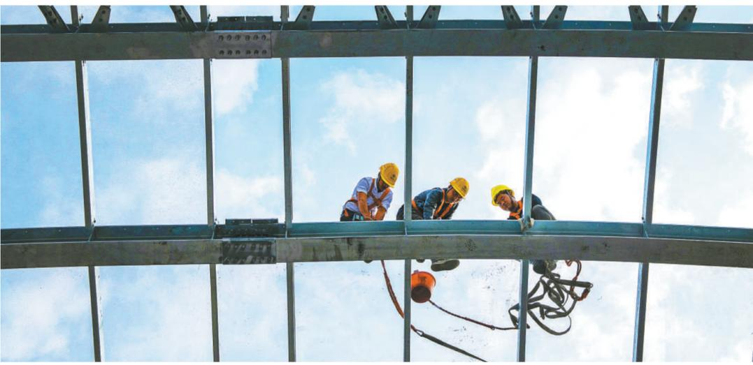
一月二十五日,位于广东省佛山市顺德区陈村佛山地铁二号线石洲站的施工现场,建设者正加快推进铁路隧道隔音屏安装。
