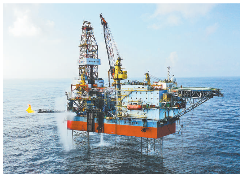
本报北京1月25日讯(记者黄晓芳)中国海洋石油集团有限公司25日宣布，自然资源部油气储量评审办公室近日审定惠州26-6油气田探明地质储量为5000万立方米油气当量，标志着我国珠江口盆地再获重大油气发现。中国海油深圳分公司总地质师高阳东表示，惠州26-6油气田的发现井测试日产原油超过500立方米、天然气60多万立方米。左图 惠州26-6油气田作业现场。(中国海洋石油集团供图)
